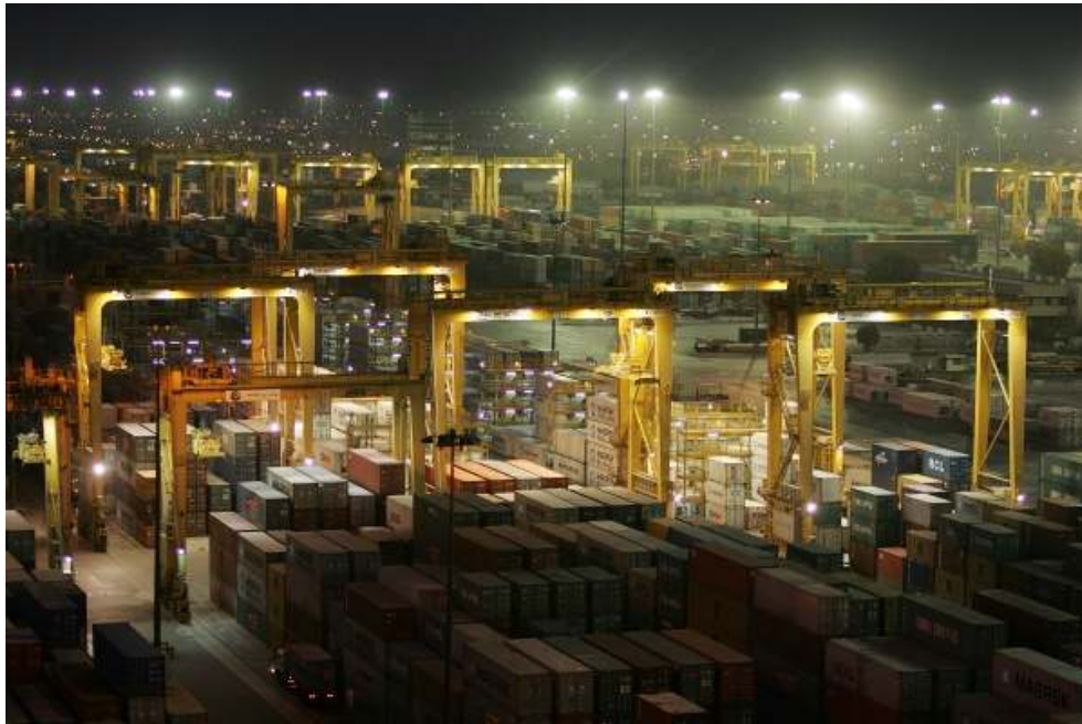
Figura 21. Terminal Jebel Ali (Dubai) I
