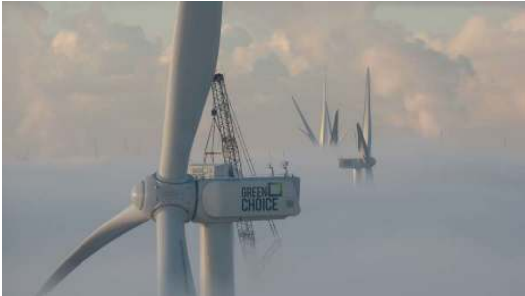
Figura 22. Instalación de turbinas eólicas en el Puerto de Rotterdam
