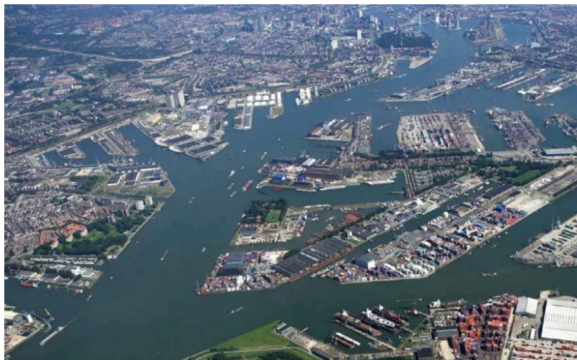
Imagen del Puerto de Rotterdam; Vista de pájaro de la CityPorts: Eemhaven y Waalhaven (derecha), Merwehaven y Vierhavens (izquierda)
